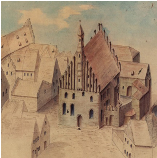
Die Hohe Schule, das Hauptgebäude der Universität Ingolstadt, 1571.
